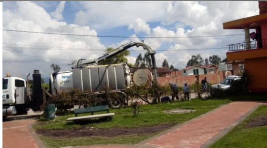
Imagen. Atención de emergencia con equipo succión presión en el municipio de Gachancipá.
