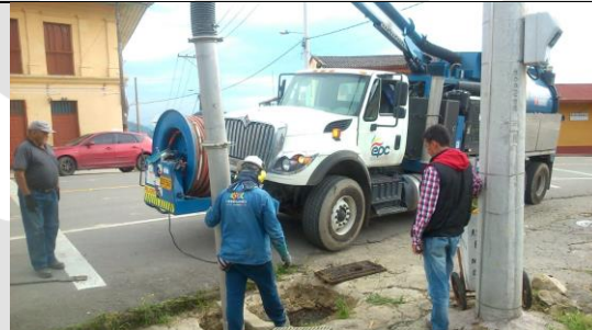
Imagen. Atención de emergencia con equipo succión presión en el municipio de Alban.
