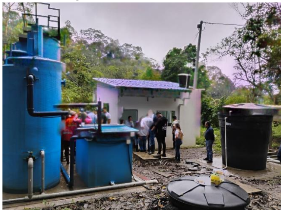
OBRA # 35. La Mesa: AUNAR ESFUERZOS TÉCNICOS Y ADMINISTRATIVOS PARA LA CONTRATACIÓN DE LA CONSTRUCCIÓN DE LA PLANTA DE TRATAMIENTO DE AGUA POTABLE VEREDA ANATOLÍ MUNICIPIO DE LA MESA, DEPARTAMENTO DE CUNDINAMARCA
