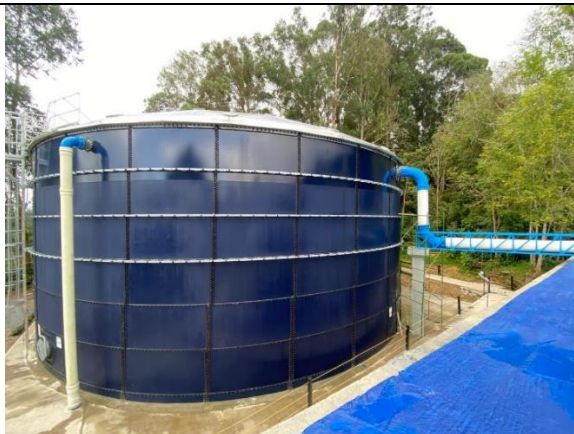
OBRA # 45. Choachí: MEJORAMIENTO Y OPTIMIZACIÓN DEL SISTEMA DE ALCANTARILLADO DEL CASCO URBANO DEL MUNICIPIO DE CHOACHÍ, CUNDINAMARCA.
