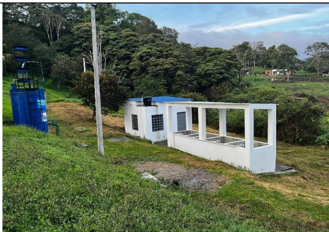
OBRA # 11. Anolaima: AUNAR ESFUERZOS TECNICOS Y ADMINISTRATIVOS PARA LA OPTIMIZACIÓN DEL ACUEDUCTO DE LAS VEREDAS LA ESMERALDA, MONTE LARGO, SAN JERONIMO, MILAN Y LIMONAL (INCLUYE PTAP) DEL MUNICIPIO DE ANOLAIMA, CUNDINAMARCA.
