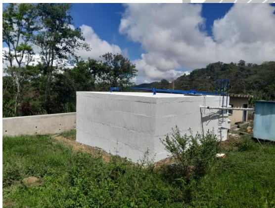
OBRA # 30. Tocaima: OBRAS DE OPTIMIZACIÓN Y CONSTRUCCIÓN DE LOS SISTEMAS DE ACUEDUCTO FASE II Y ALCANTARILLADO FASE II, ZONA URBANA DEL MUNICIPIO DE TOCAIMA, CUNDINAMARCA.
