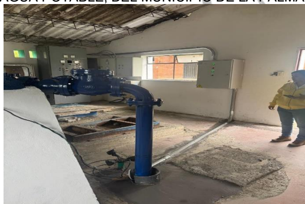
OBRA # 22. Arbeláez: CONSTRUCCIÓN PLAN MAESTRO ALCANTARILLADO SANITARIO FASE I Y PLUVIAL FASE II DEL MUNICIPIO DE ARBELÁEZ, CUNDINAMARCA.
